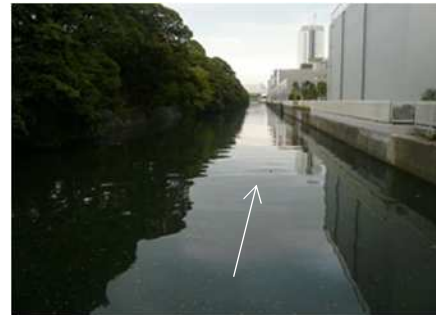
汐留川（汐留第二ポンプ所付近）
