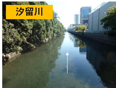
汐留第二ポンプ所付近
