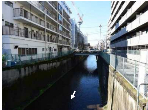
妙正寺川落合橋付近
