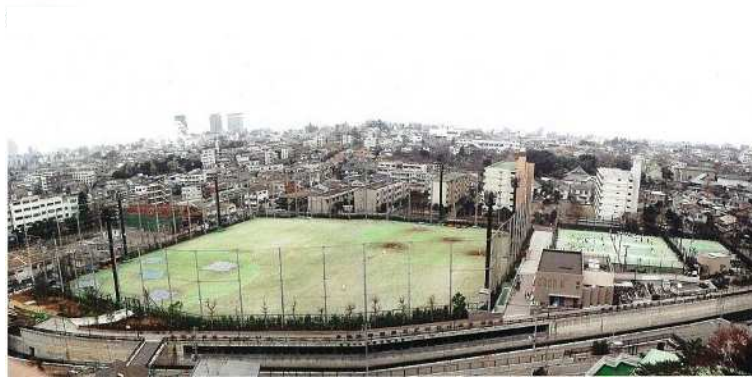
図2-8 上高田調節池 全景
