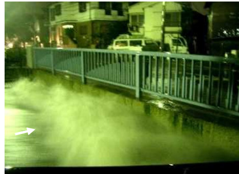
平成17年9月妙正寺川天神橋
