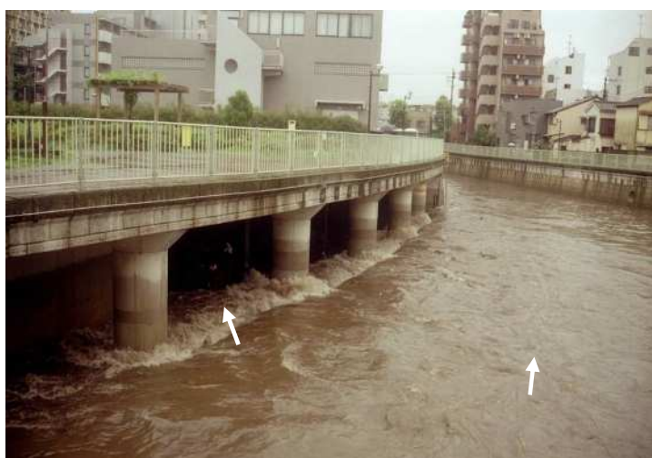
图2-5 神田川取水施設取水状況
