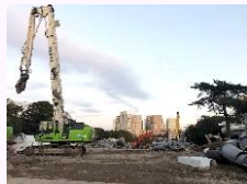
解体中（12月中旬頃）
