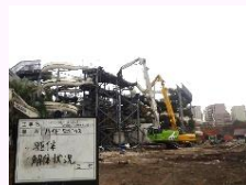
解体中（12月上旬頃）
