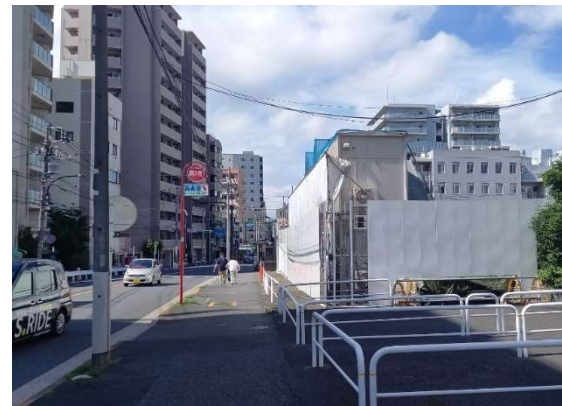
牛込保健センター移設後 排水管工事、企業者工事着手予定
