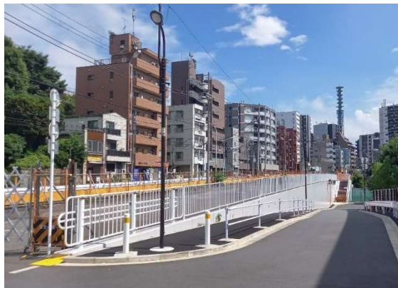
擁壁工事完了 順次、排水管工事、企業者工事着手予定
