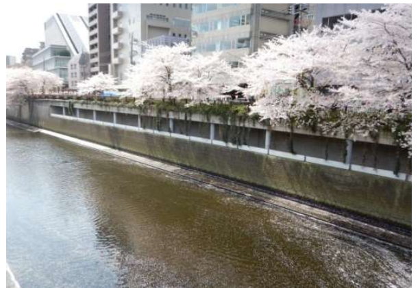
田楽橋下流取水施設
