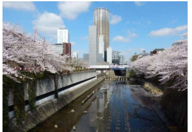
田楽橋上流取水施設
