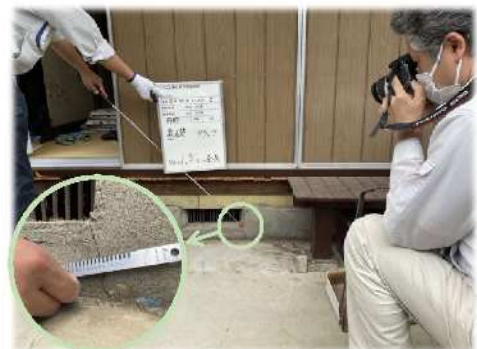
外壁・基礎調査
