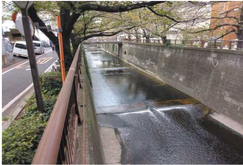
① 起点側の下流側から上流に向けて撮影
