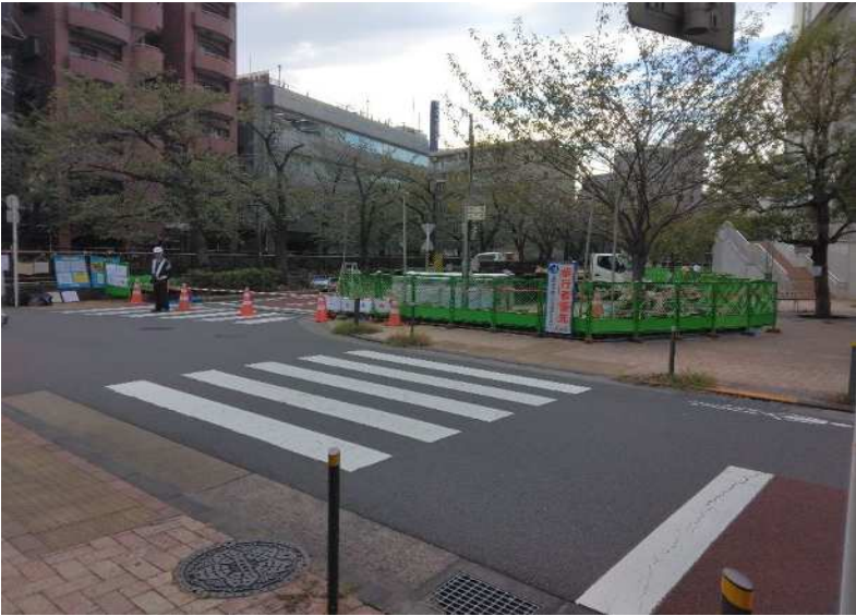
③作業基地 下流側より撮影
