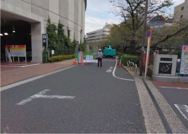
④作業基地 上流側より撮影
