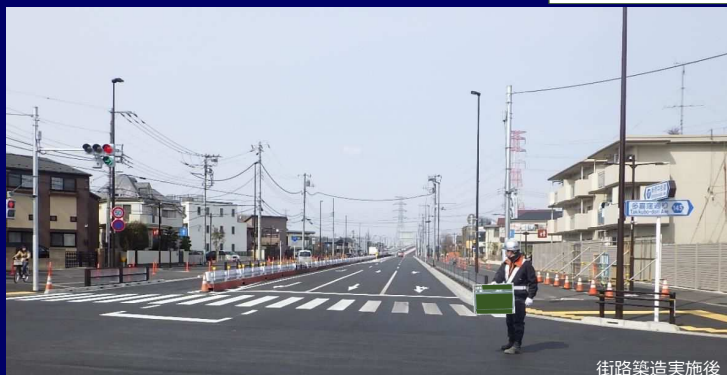
街路築造実施後
