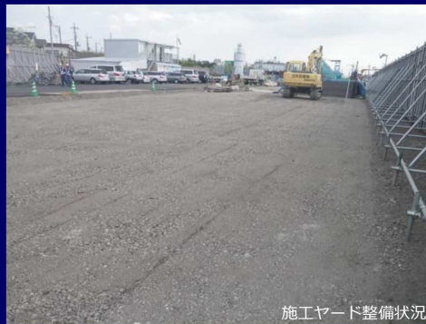
施工ヤード整備状況
