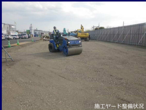
施工ヤード整備状況
