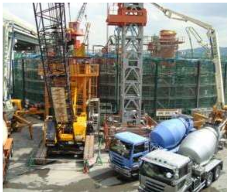
立坑施工時の足場【参考】
