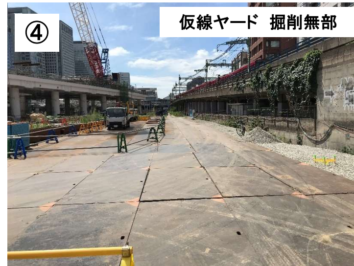
工事に用通路鉄板敷設状況
