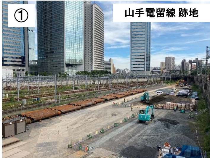
作業ヤード整備状況
