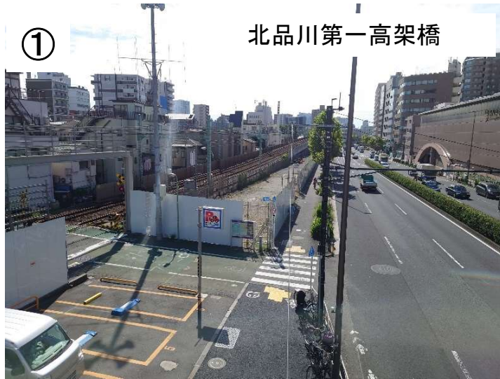
作業ヤード整備状況
