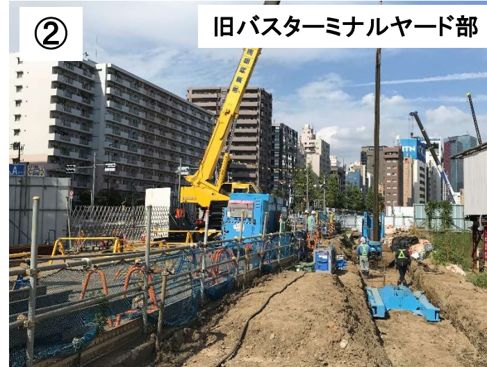
鋼矢板打設 布堀・試掘調査状況
