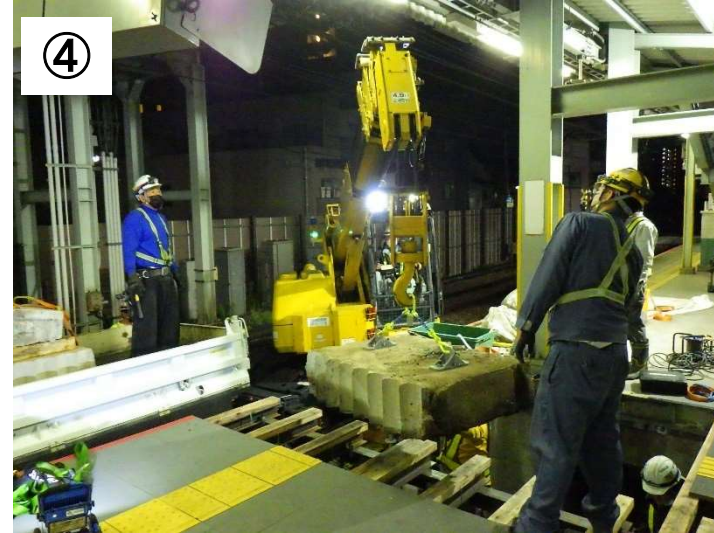
北品川駅部 ホーム仮設化状況
