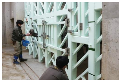
準間接飼育のための柵 「プロテクトッド・コンタクト・ウォール」(PCウォール)
