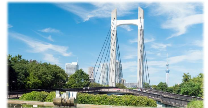
長寿命化計画の対象となる公園橋
