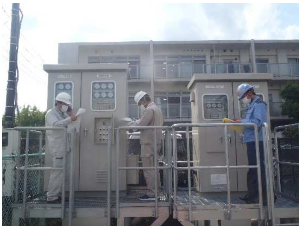
樋門の開閉操作状況
