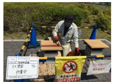
日常からの修繕作業
