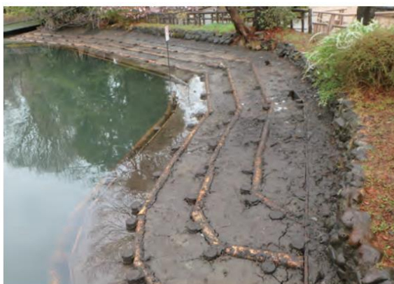
写真1 整備後の弁天池下流浅場
