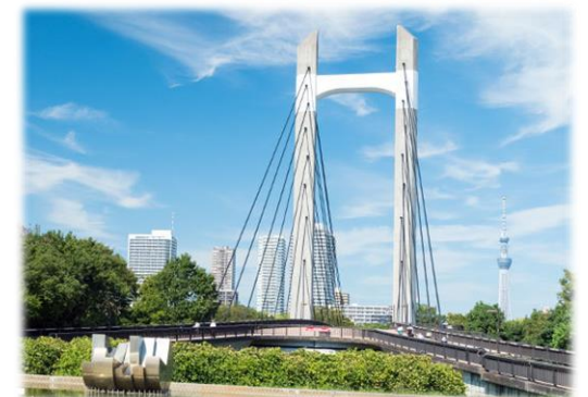
長寿命化計画の対象となる公園橋
