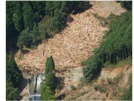
福岡県朝倉市 須川第1砂防堰堤 ※既設砂防堰堤が大量の流木を捕捉 (平成29年7月九州北部豪雨)
