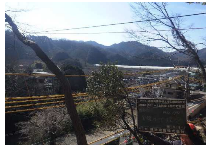
道上斜面上での介錯ロープを用いての伐木状況
