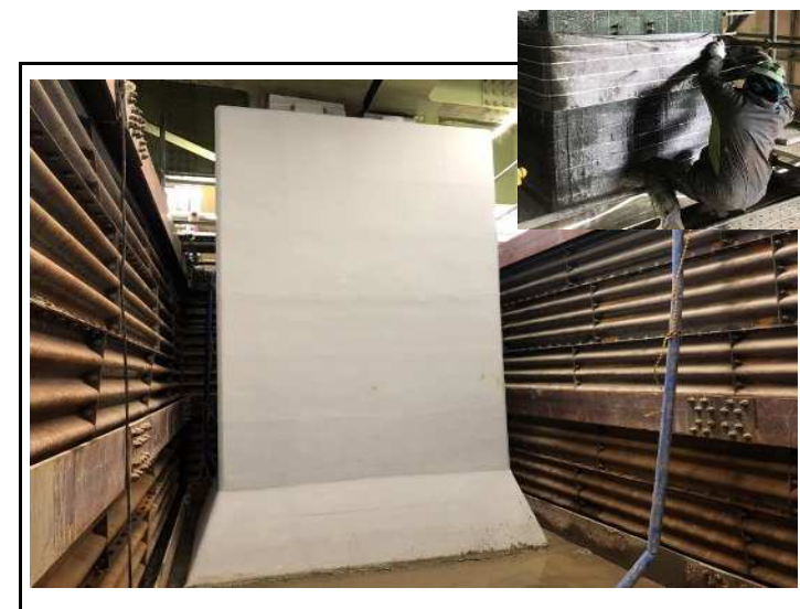
フーチング基礎まで掘削し、炭素繊維シート補強を施工
