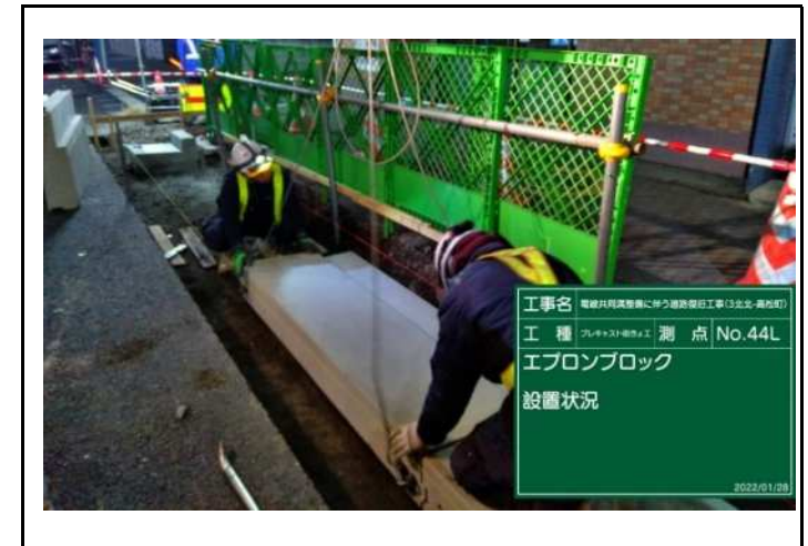
プレキャスト街きょ エプロンブロック設置状況
