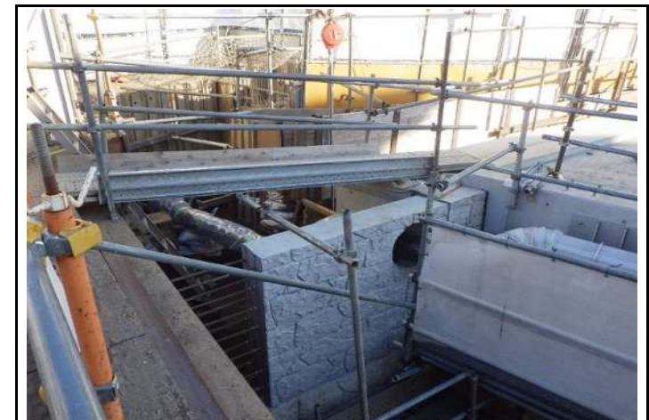
左岸護岸先行構築
