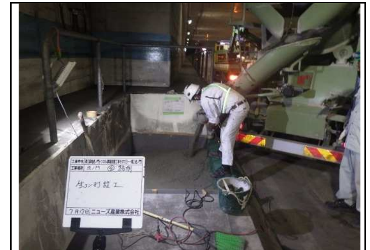
標識基礎コンクリート増設状況
