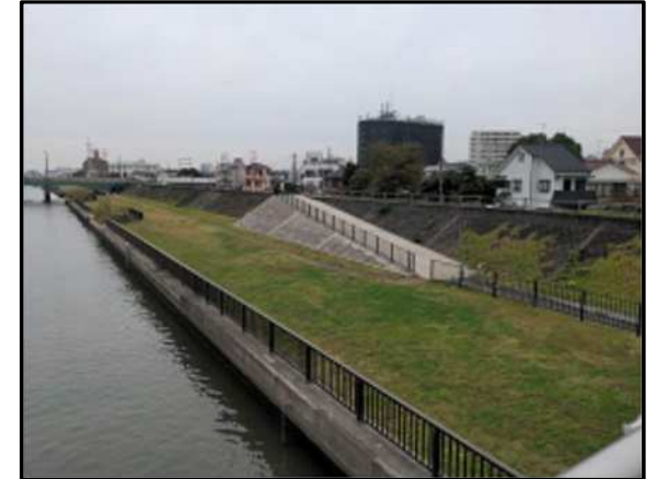
施工後（地盤改良後）
