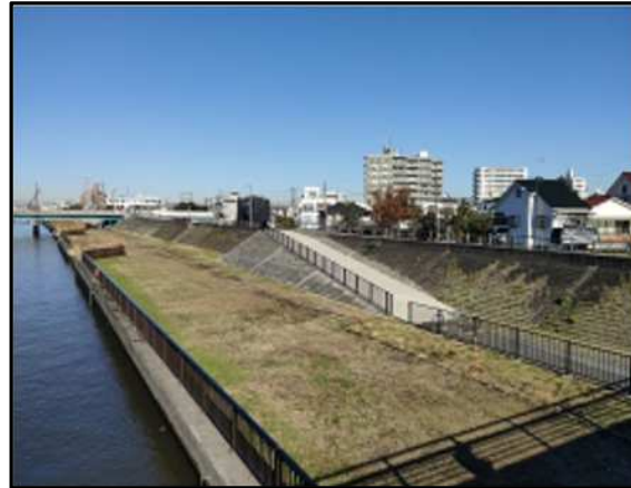
施工前（地盤改良前）
