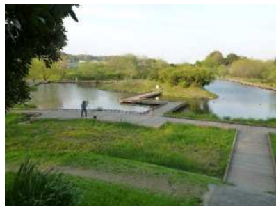
掘込み式 (金山調節池)
