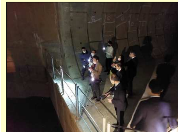
環状七号線地下調節池
