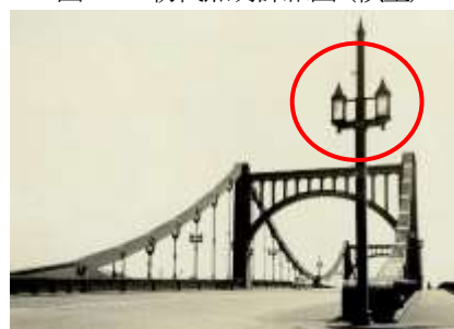
写真-3 清洲橋の照明(縦型)
