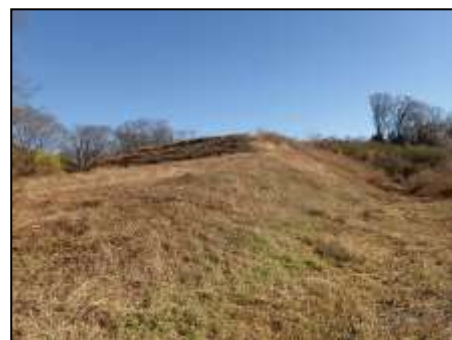
写真—1 公園内の盛土箇所
