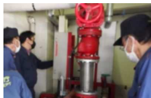
消火設備点検
