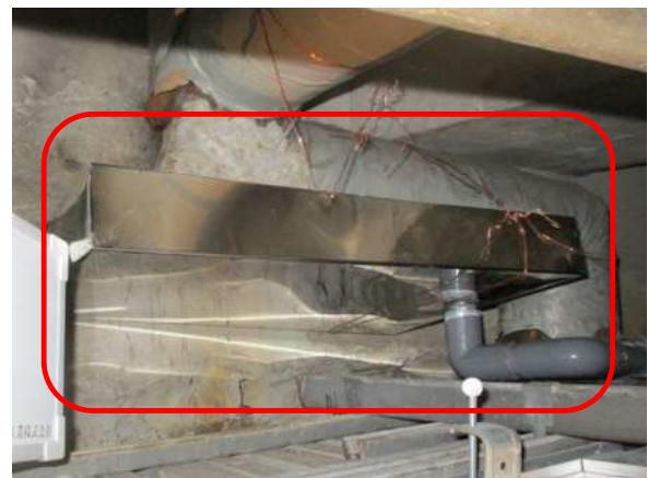
漏水管への受皿設置
