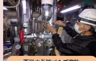
高温水系統バルブ交換
