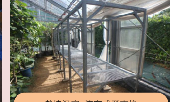
栽培温室C棟育成棚交換
