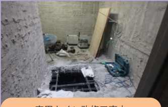
客用トイレ改修工事中
