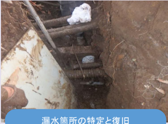
漏水箇所の特定と復旧
