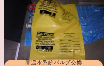
高温水系統バルブ交換 (アスベスト検査)
