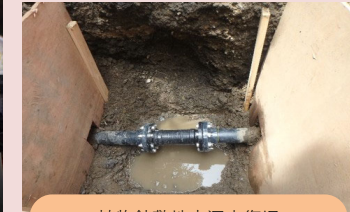
植物館敷地内漏水復旧
