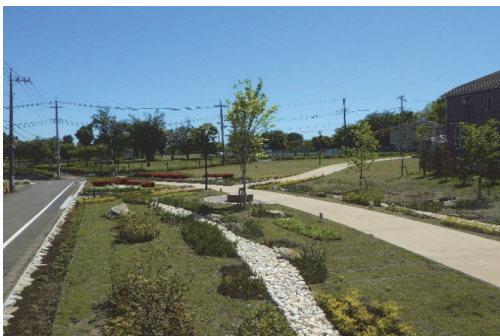
六仙公園 園地整備(東久留米市) 六仙公園中央西側の一部が開園した(令和5年1月)。新たに浸透型植栽帯や休憩施設等を整備した。
