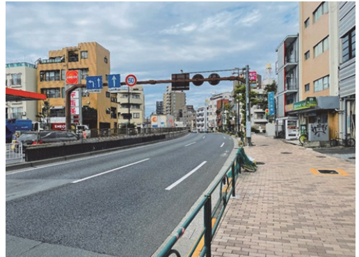
無電柱化事業 (世田谷区大原一丁目 環七通り) 都市防災機能の強化、安全で快適な歩行空間の確保、良好な都市景観の創出を目的としている。
