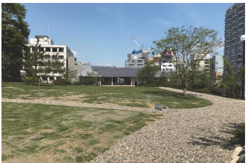
旧岩崎邸庭園 芝庭復元及び拡張・管理所の新築(台東区・文京区) 芝庭の復元と拡張整備及び管理所の新築工事を並行して実施し、新規開園した(令和5年6月)。芝庭の拡張部分は新管理所の3階に接続している。
