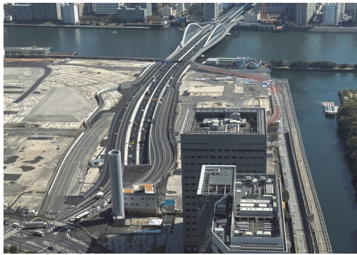
環状第2号線 令和4年12月の築地から新橋までの本線約1.4km区間の開通により、環状第2号線の全線が開通した。これにより、臨海部と都心部の連絡を強化し、地域交通の円滑化や避難経路の多重化による防災性の向上が図られる。
