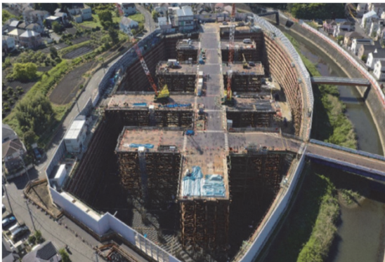
境川金森調節池 年超過確率1/20規模の降雨(時間最大雨量65ミリ)に対応する調節池を整備し、洪水の一部を流入させて貯留させることで、近年頻発する集中豪雨による水害の軽減を図ります。
