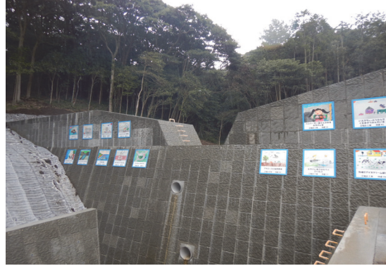
三宅村 西川西支川地区 発電所及び都道を保全対象とする砂防施設で、令和5年2月に完成した。地元の小学校の防災教育にも利用されている。
