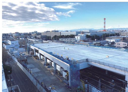
西武新宿線他2路線(東村山駅付近)連続立体交差事業 西武新宿線、国分寺線及び西武園線(東村山駅付近)の約4.5kmについて鉄道の高架化工事を行っている。これにより、5ヶ所の踏切が除却される。
