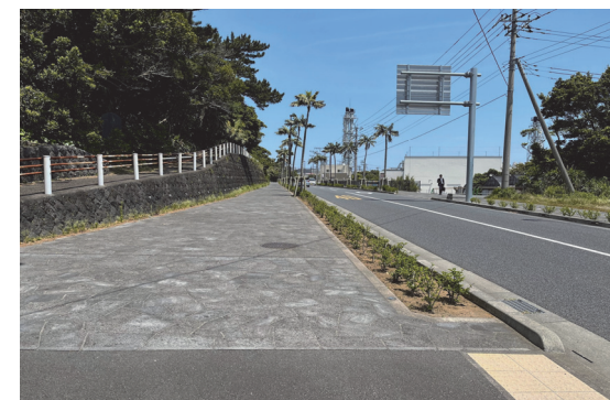
一般都道神湊八重根港線(八丈町) 八丈島の中心部を東西に横断する道路のうち、約2.3kmの道路拡幅工事が令和2年3月に完了した。これにより、安全な歩行空間が確保され、防災性の向上が図られた。
