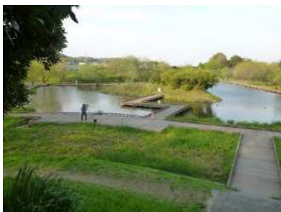
掘込み式 (金山調節池)
