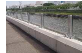
防潮堤高上げ
