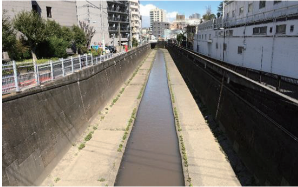
写真-1 神田川 和田見橋付近
