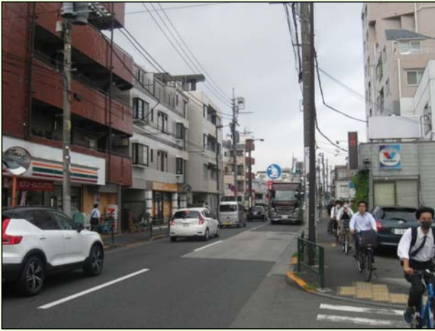
○整備予定区間 (下井草五丁目付近)
