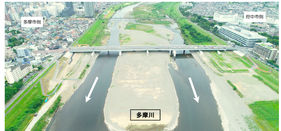
8年目工事完了状況（全景）（多摩川下流側から上流側を望む）令和5年6月撮影
