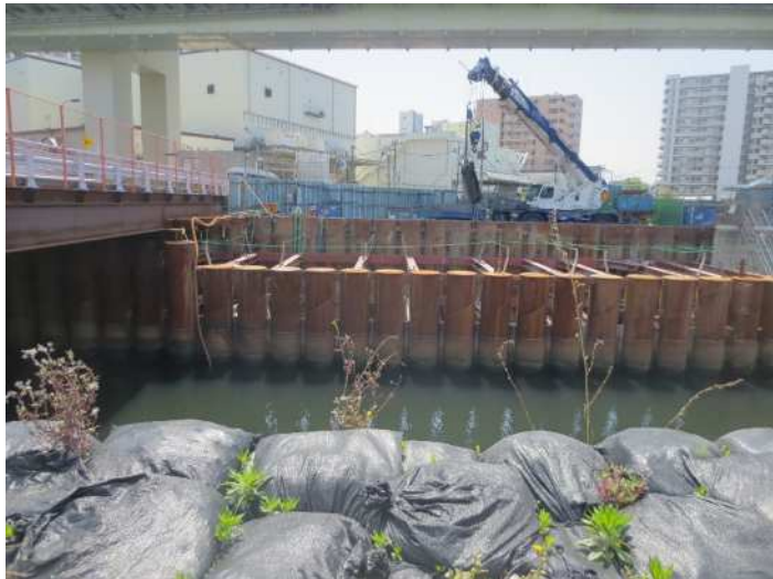
石神井川整備工事（新柳橋上下流右岸）の状況
