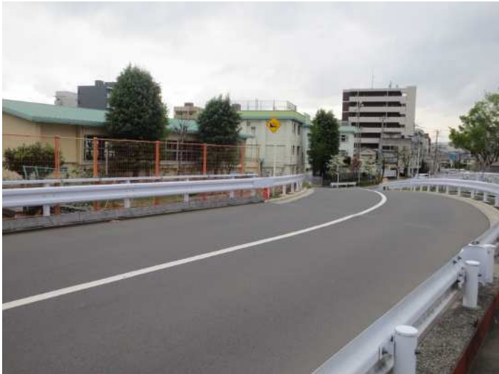
新柳橋架替に伴う仮橋
