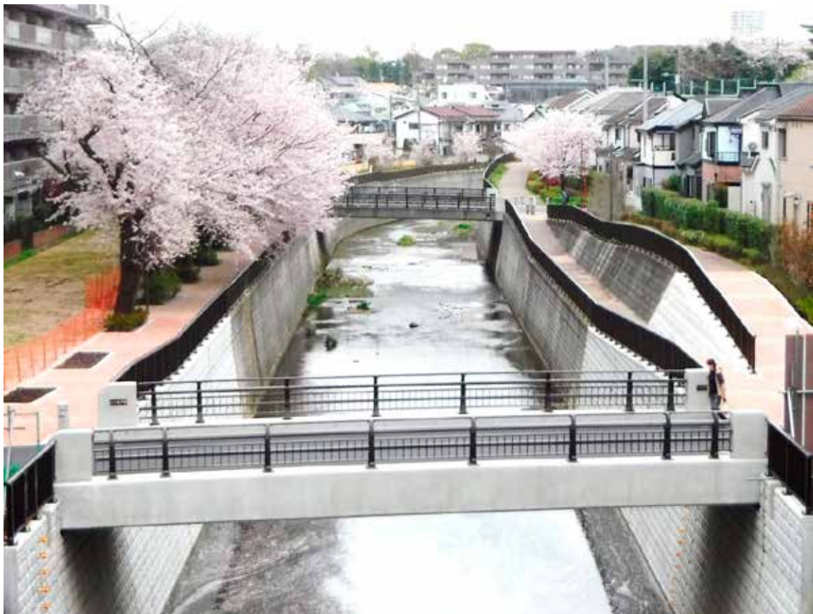
石神井川整備事業 （練馬区石神井台四丁目、上石神井三丁目付近） ～護岸整備状況～
