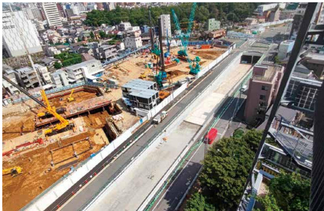
環状第5の1号線（雑司ヶ谷）整備 （豊島区雑司ヶ谷三丁目～南池袋二丁目） ～三工区（豊島区役所付近）の整備状況～
