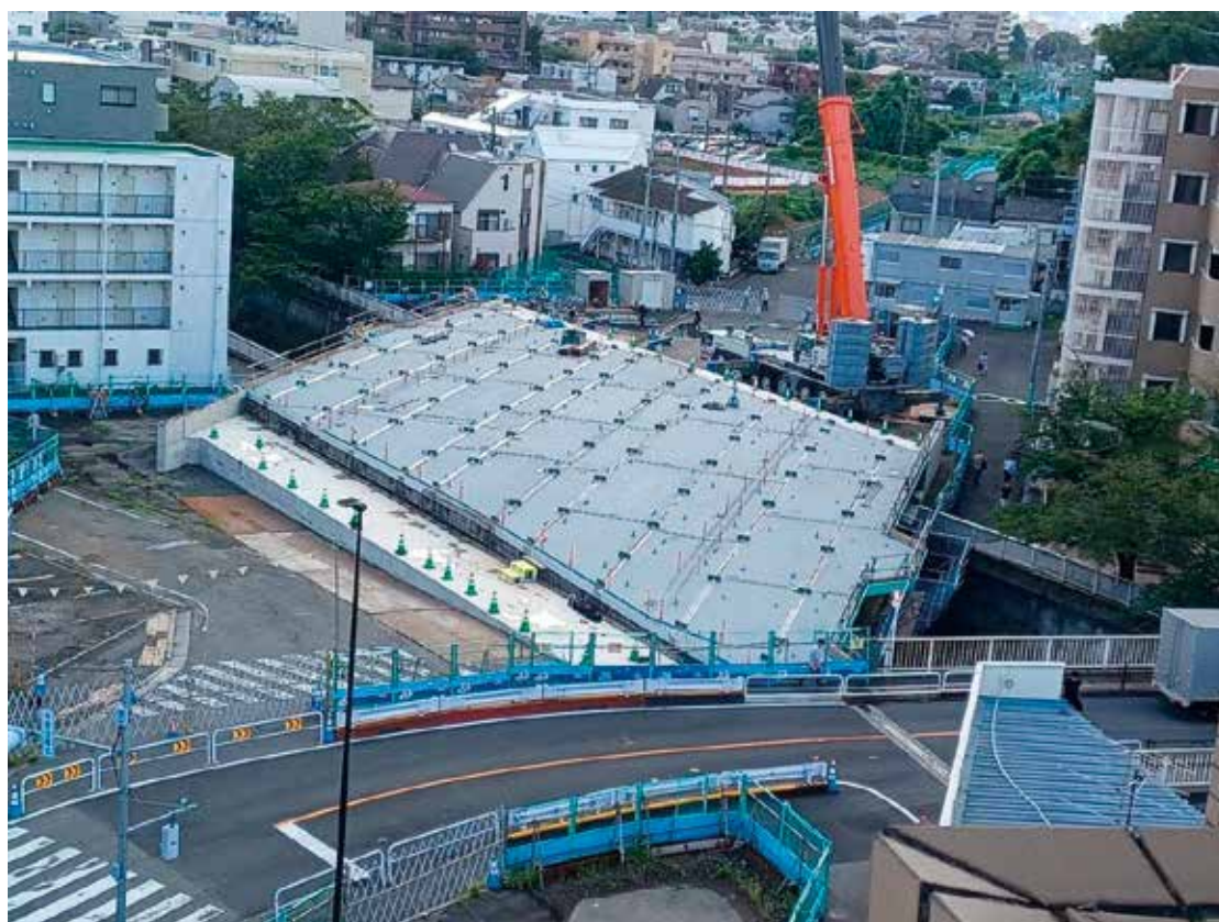
放射第36号線（氷川台橋梁）整備 （練馬区桜台三丁目～氷川三丁目） ～鋼けたの架設状況～
