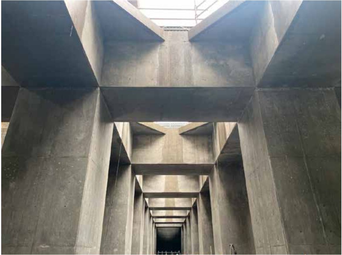
城北中央公園調節池（一期）工事その2 （板橋区小茂根五丁目、練馬区羽沢三丁目付近） ～調節池内の内部構築状況～
