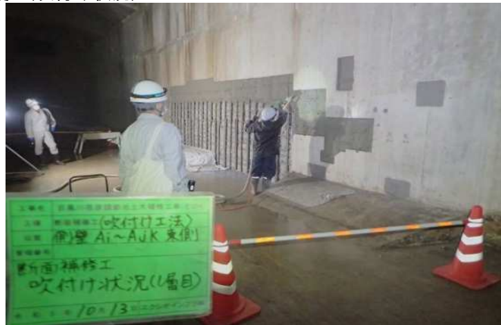
②断面修復工(吹付け状況)
