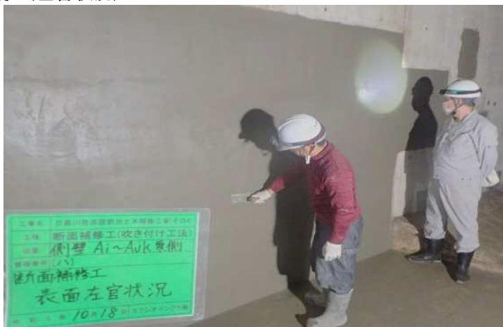
③断面修復工(左官状況)
