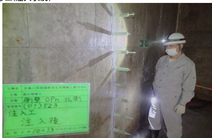
⑤漏水補修工(注入状況)
