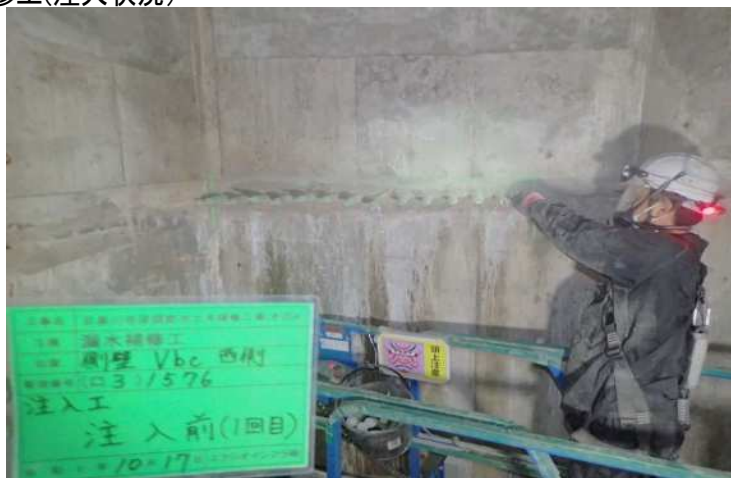
④漏水補修工(注入状況)
