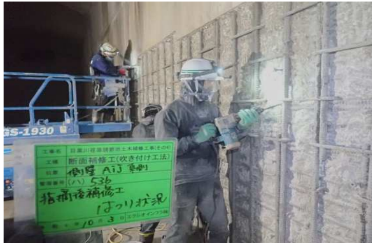
①断面修復工(ハツリ状況)
