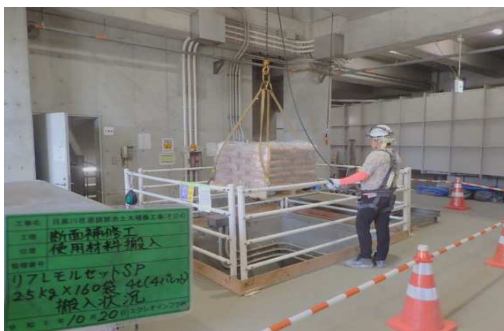
⑥使用材料搬入状況
