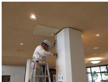
雨漏り対策工事
