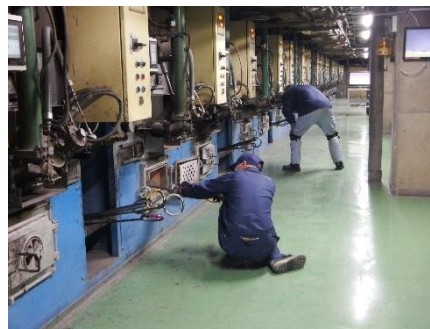
火室での作業
