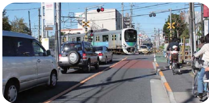
府中街道(久米川第2号踏切)の状況
