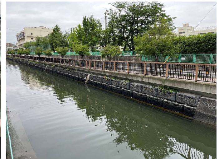
親水護岸の整備事例②
