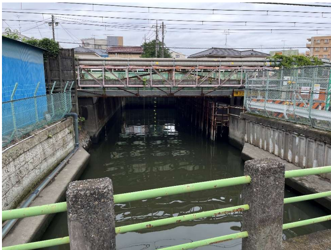
JR東海道本線 交差箇所
