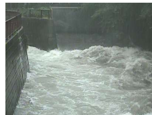
増水時の蛇崩川合流点
