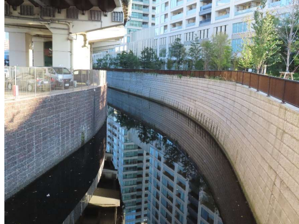
古川(新古川橋付近)整備状況
