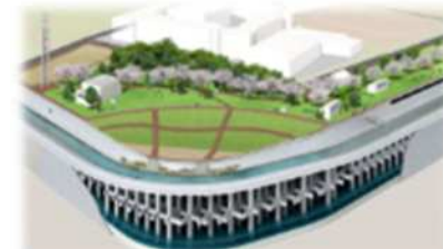
①城北中央公園調節池（一期） 都立城北中央公園（練馬区・板橋区） 規模：約250,000m 3
