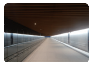
第2号線III期区間(1工区)
