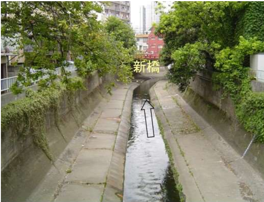
整備前(新橋上流)
