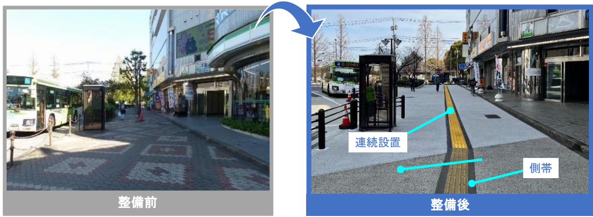
写真4.5.4 視覚障害者誘導用ブロックの連続設置
