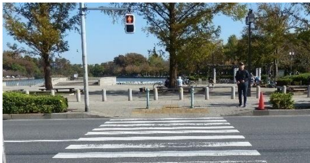
写真4.6.2 エスコートゾーンが設置されていない横断歩道
