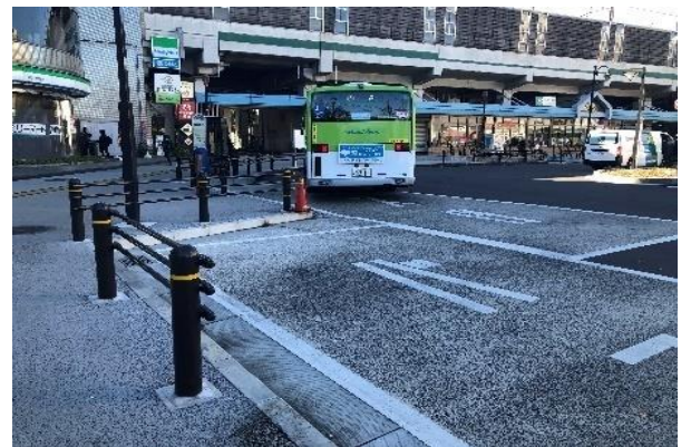
写真4.7.4 三角形切り込み型へ改修
