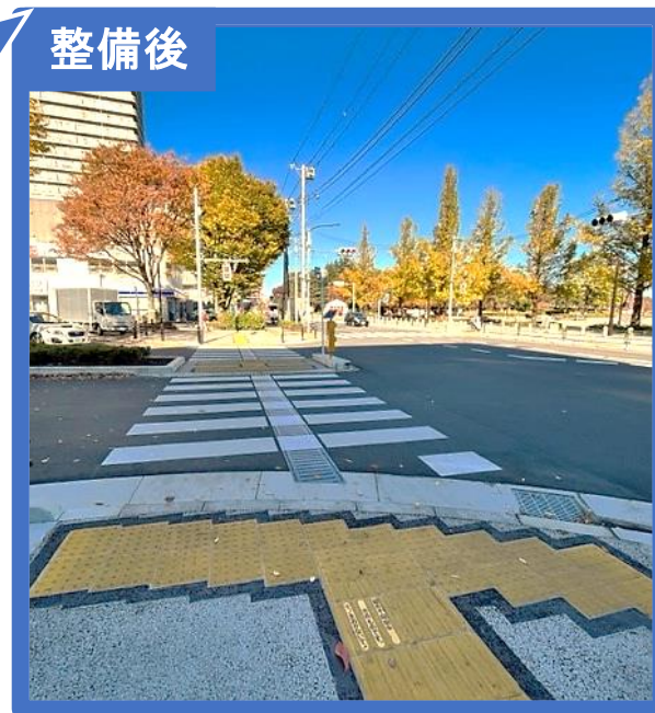
写真4.5.9 現在の基準 (JIS 規格) の視覚障害者誘導用ブロック
