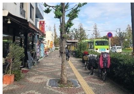
写真4.5.3 植栽ますに近接設置された視覚障害者誘導用ブロック
