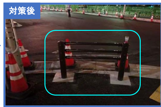
写真5.1.4 工事中に防護柵を先行設置し 安全性を確保
