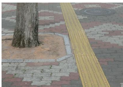
写真4.12.4 高木植栽ますに近接した視覚障害者誘導用ブロック
