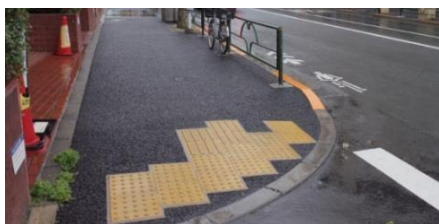
《アスファルト舗装》
