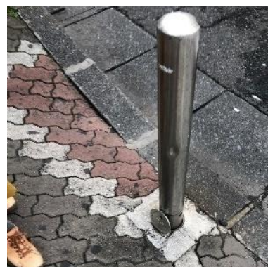
写真4.1.2 ステンレス製の車止め
