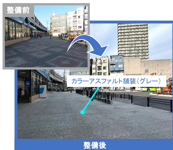
写真4.3.4 タクシー降り場付近の舗装
