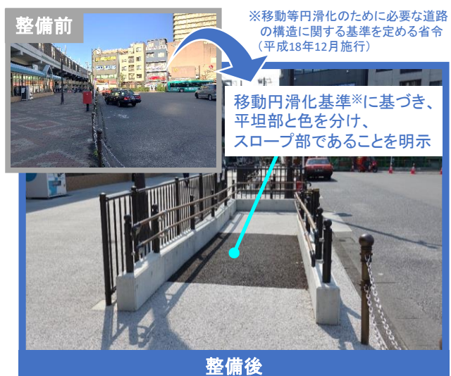
写真4.4.4 スロープの整備
