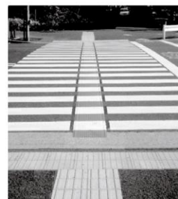
【写真3.1】 エスコートゾーンの設置例
