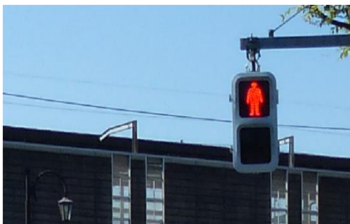
写真4.6.1 音響式信号機が設置されていない信号機
