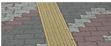
写真4.5.1 輝度比が確保されていない視覚障害者誘導用ブロック
