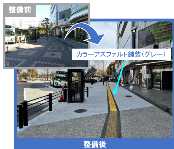
写真4.3.5 バス降り場付近の舗装
