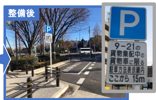
写真4.10.4 荷さばきスペース及び運用のための標識
