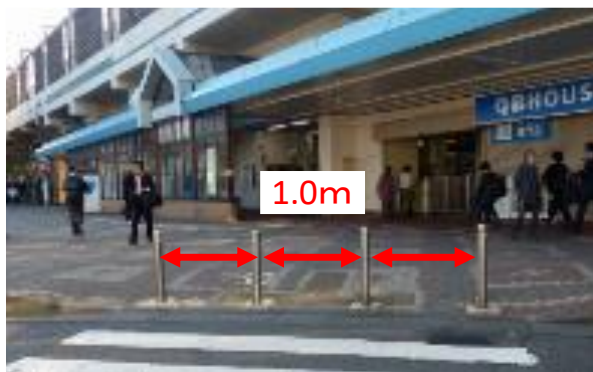
写真4.1.1 車止めの設置位置
