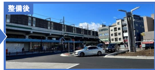
写真4.8.4 タクシープール設置により 待機車両がなくなったタクシー乗降場
