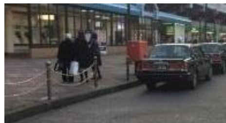
写真4.4.2 タクシー降り場の段差
