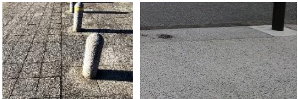
写真4.3.3 (左)浮間公園、(右)今回舗装
