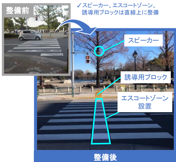
写真4.6.4 公園前の横断歩道のバリアフリー化
