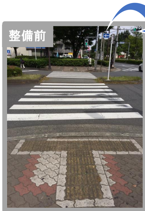
写真4.5.8 JIS 規格ではない視覚障害者誘導用ブロック
