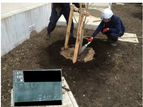
⑥植栽状況写真（灌水）
