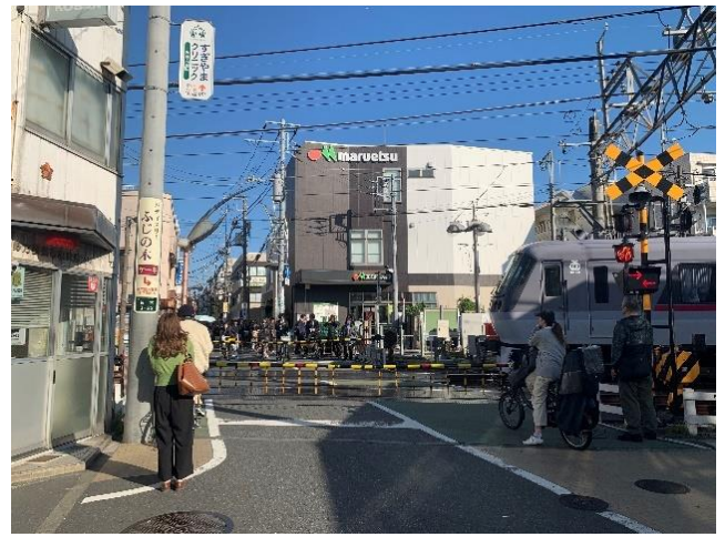
都立家政第1号踏切道
