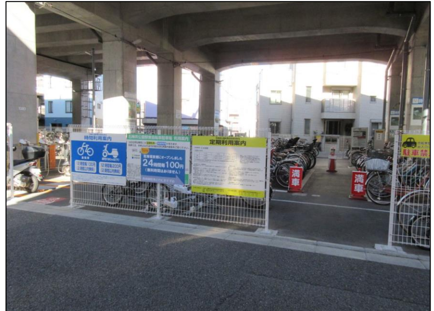
高架下を利用した駐輪場(石神井公園付近)
