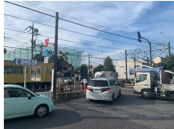
上井草第2号踏切道
