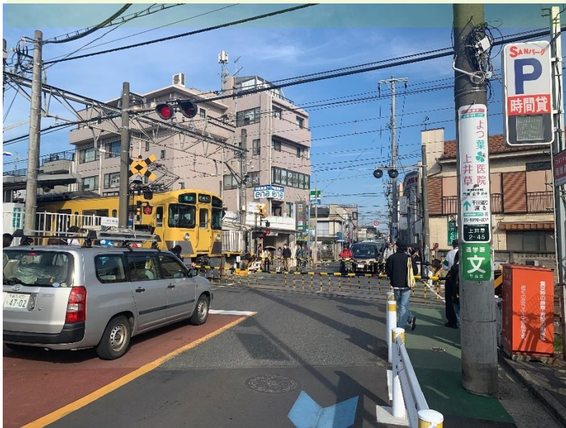
上井草駅前周辺(井荻第6号踏切)の状況
