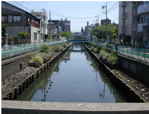
写真 4-3 四之橋から下流の現況
