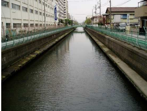
写真 2-4 直壁護岸状況（四之橋上流）
